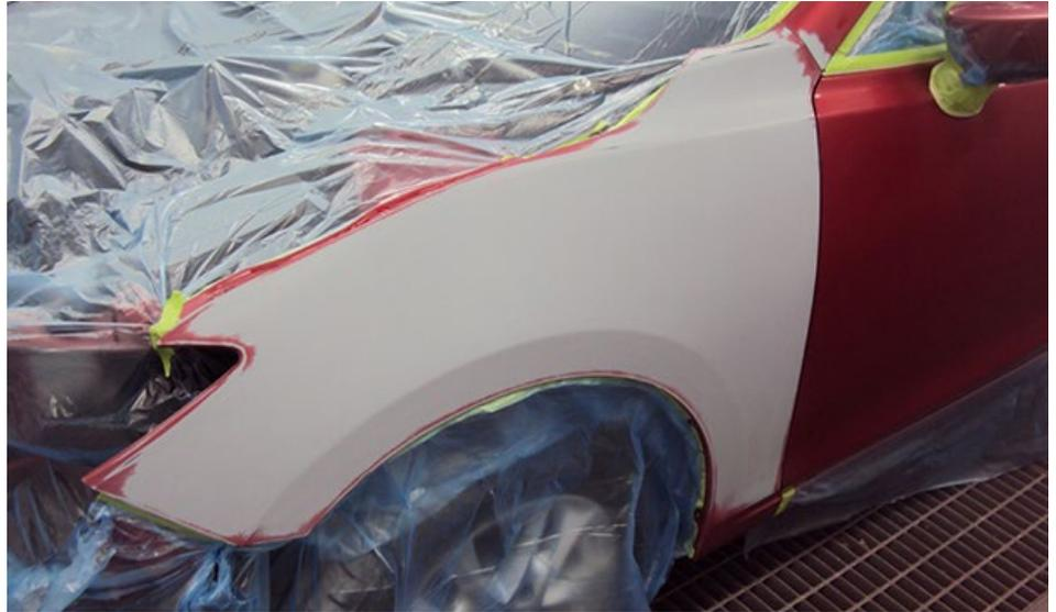
■ Preparación de cada pieza para aplicación de acabado tricapa
