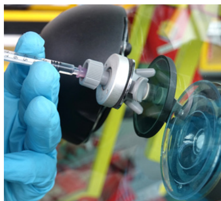
■ Inyección de resina
