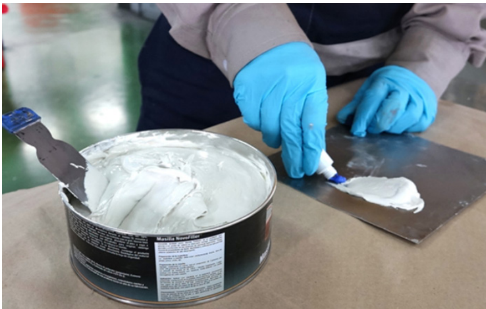
■ Preparación de masilla con su respectivo catalizador según recomendaciones.
